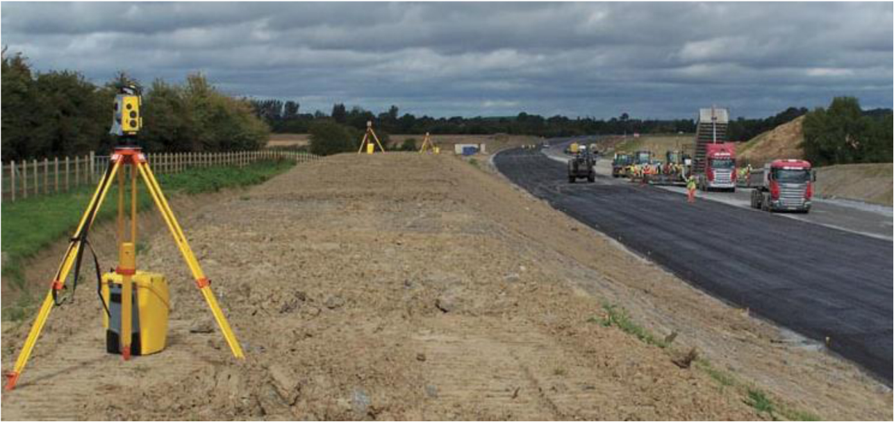
Joonis 2-17. Tahhümeetriga juhitud asfaldilaotamine
